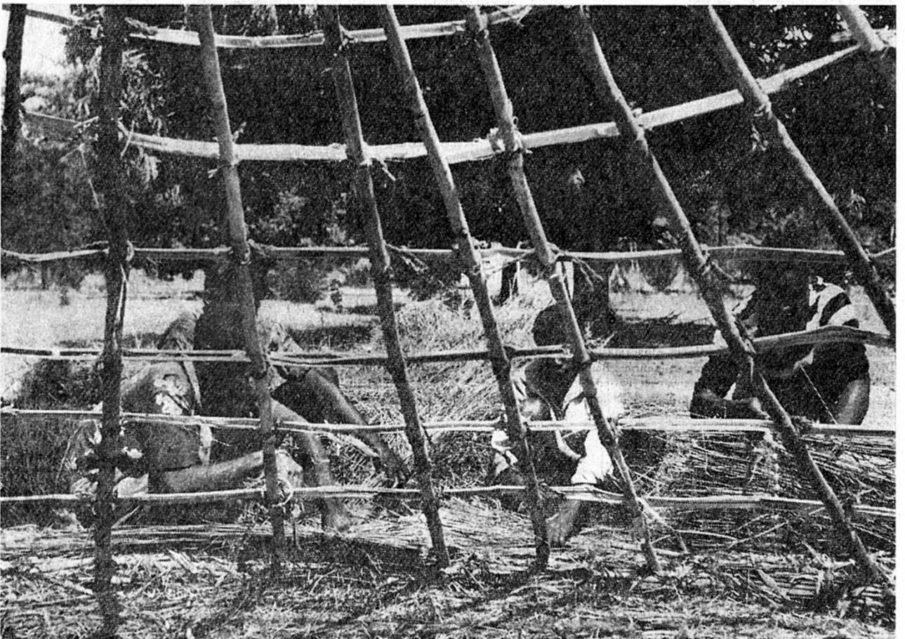
Errichtung des Bambusgerüsts beim Bau eines Hühnerhauses mit einheimischem Material.
