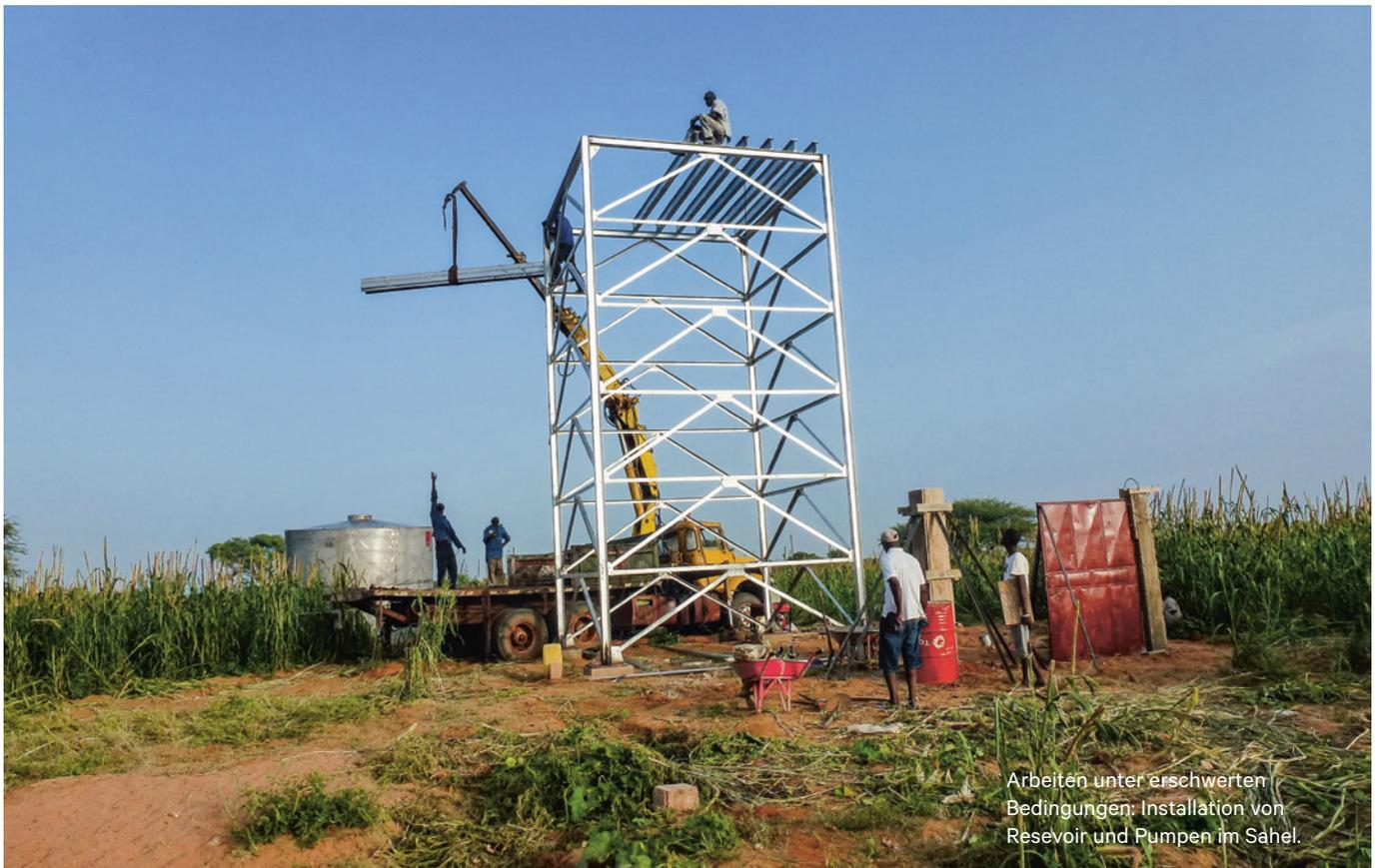
Arbeiten unter erschwerten Bedingungen: Installation von Reservoir und Pumpen im Sahel.
