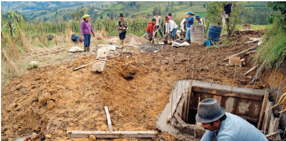
La communauté de Canduya s'est engagée durant deux ans pour construire son système d'adduction d'eau d'irrigation. Ici, la construction d'un réservoir pour atténuer la pression.
